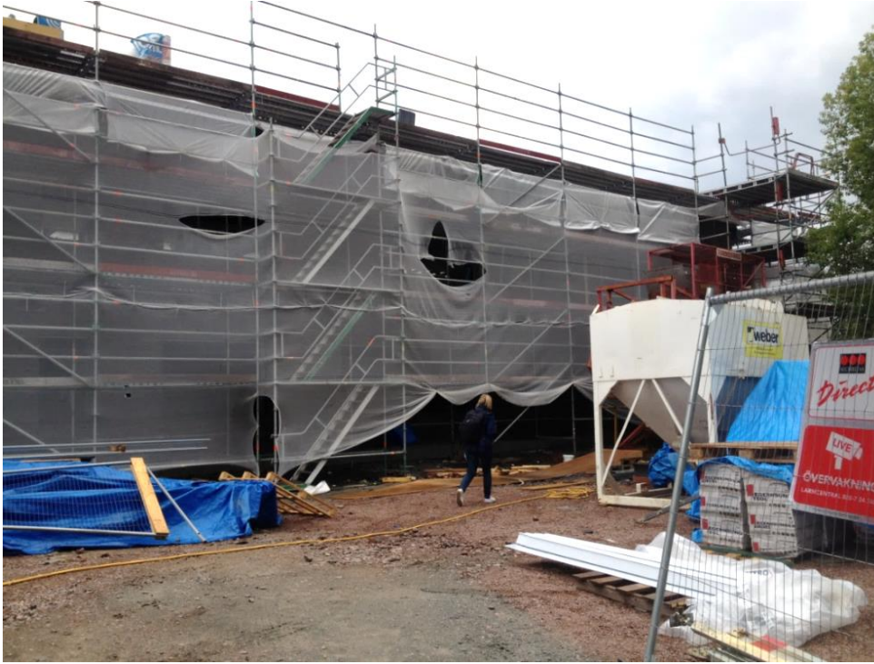
Bild 3.1.2d: Bergsgårdsskolan aug 2014. Fasaden (skalmur av tegel) är snart färdigställd. Invändigt har isolering av klimatskalet påbörjats.
