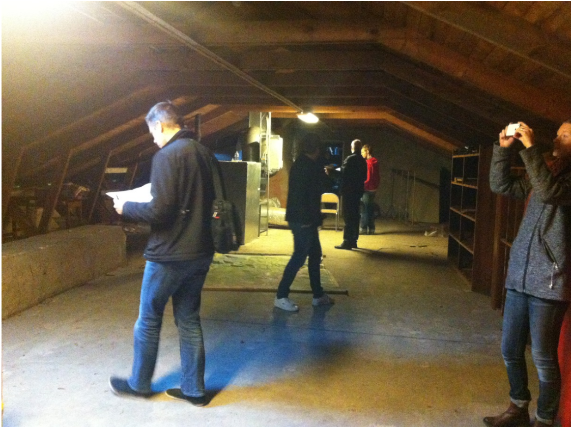
Bild 4: Johannebergsskolan okt 2014. Konsultgruppen inspekterar befintligt ventilationssystem.
