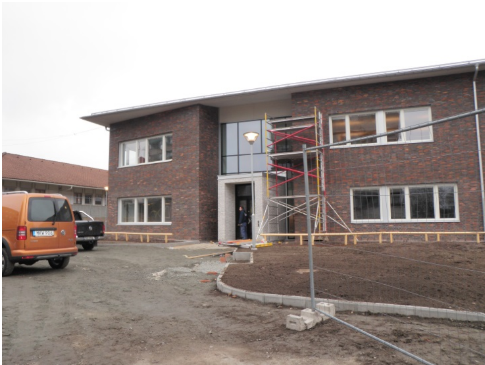
Bild 12: Bergsgårdsskolan mars 2015. Slutbesiktning.
